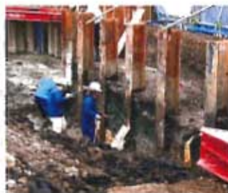
② 根伐掘削 (2/24)
